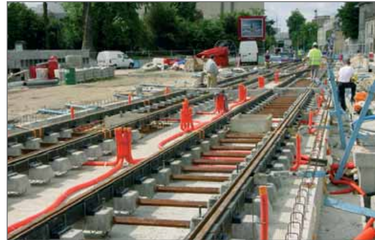
Plataforma tranvía ferroviario
